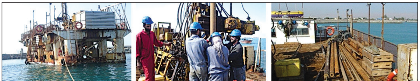
شکل ۳- دستگاه حفاری و مغزه‌گیری از رسوبات بستر دریا.
