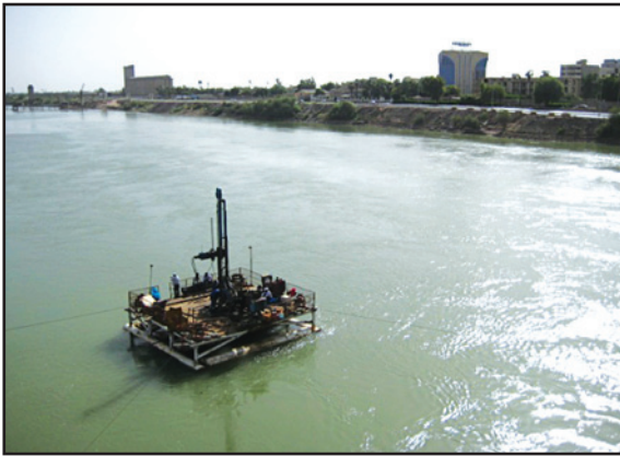
عکس ۲- حفاری در بستر کارون، جنوب پل نادری، نمونه‌های سن یابی شده با روش ترمولومینسانس از این حفاری‌ها به دست آمده‌اند. نگاه به سوی جنوب باختر.
