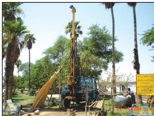
عکس ۷- گمانه حفر شده با مختصات X=279002, Y=3467516 در ساحل خاوری کارون. همانگونه که در متن آورده شده این گمانه از ژرفای ۱۸ تا ۳۳ متر با سازند آغاچاری برخورد کرده است. بر اثر عملکرد گسل اهواز، سازند آغاچاری به صورت گسل سنگ درآمده است (عکس ۸) با توجه به نتایج و مختصات این گمانه محل گذر گسل اهواز، در ساحل خاوری کارون تعیین شده است. نگاه به سوی جنوب باختر.
