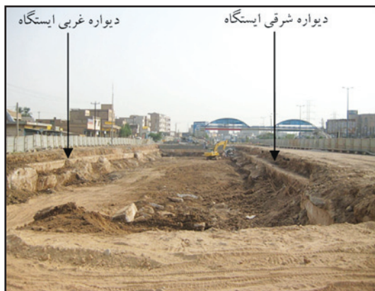
عکس ۶- نمایی از ایستگاه مرکز فرهنگی. در این ایستگاه در فاصله تقریبی ۲۵ متر، ژرفای سنگ بستر از حدود ۸/۵ متر در دیواره خاوری به ۱۰/۵ تا ۱۱ متر در دیواره باختری می‌رسد.
