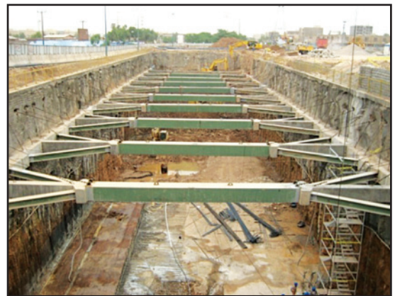
عکس ۳- نمونه‌ای از یک ایستگاه مترو که عملیات خاک برداری در آن به پایان رسیده است. این عکس شرایط ایجاد شده برای دیدن لایه‌های زیرسطحی را نشان می‌دهد. نگاه به سوی شمال.
