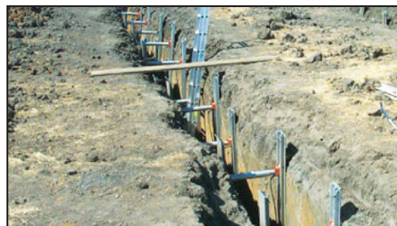
پیوست ۲- نمایی از یک ترانشه مطالعاتی حفر شده در کالیفرنیا
