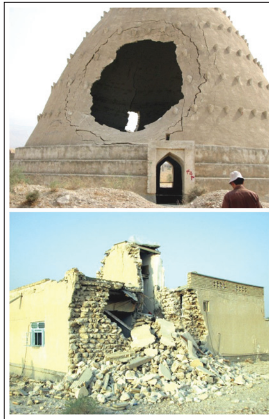
شکل ۹- رمبش در ساختمان یک آب انبار محلی (بالا) و ویرانی یک منزل مسکونی (پایین).
