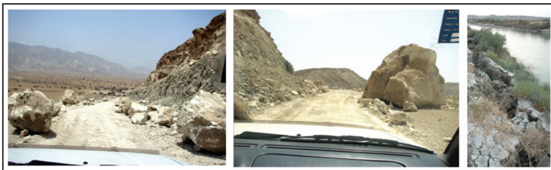
شکل ۱۰- سنگ افتهای سترگ در جاده خاکی (چپ و میانه) و لغزش خاک در کناره‌های استخر کوچک رودخانه شور پیرامون رومرکز زمین‌لرزه (راست).
