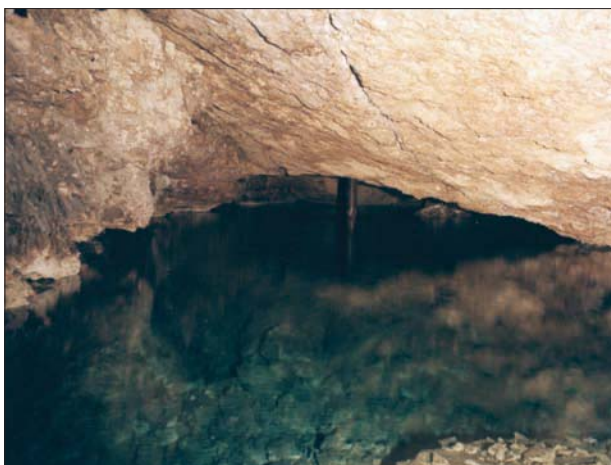
عکس ۶- لوله پمپاژ آب که ۳ متر در درون آب قرار گرفته است
