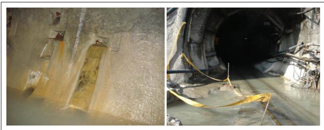
شکل ۵- الف) حجم آب ورودی به تونل کرج در محل پرتال؛ ب) ورود آب به تونل از میان سگمنت‌ها.
