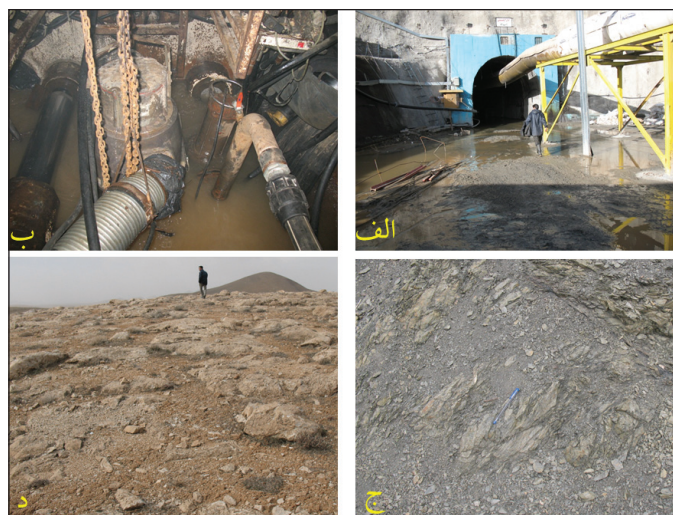
شکل ۳- تونل قمرود: الف) آب ورودی به تونل در پرتال؛ ب) پمپاژ آب درون تونل؛ ج) شست و فیلت‌های مسیر و د) سنگ‌های کربناته محدوده.
