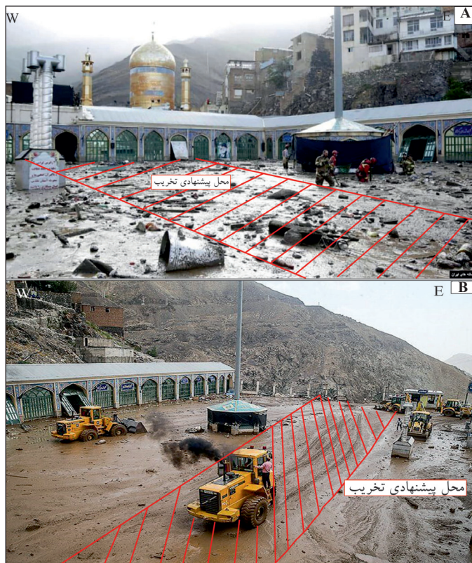
شکل ۸- پیشنهاد تخریب بخشی از حیاط جنوبی باز کردن مسیر کانال اصلی رود (A) نگاه به سمت شمال، (B) نگاه به سمت جنوب.
