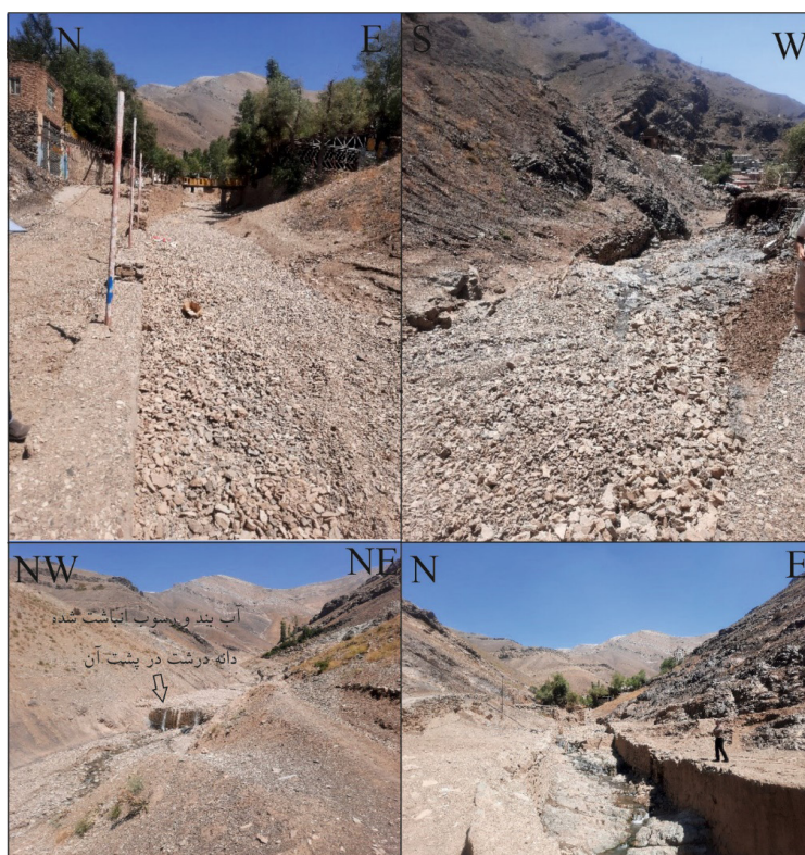
شکل ۷- نمایی از آب‌بندهای ساخته شده در مسیر رود در بالادست امامزاده.
