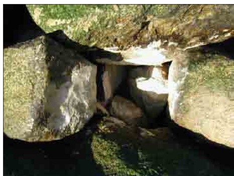
شکل ۱۶- سایش قطعات سنگ مجاور هم ناشی از جایگذاری نامناسب
