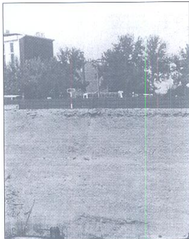
عکس ۲- نمونه ای از دیواره های عمودی پایدار در آبرفت‌های سیمنی شده سری C (جنوب شرقی پارک لاله)
