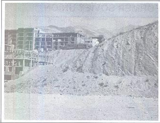
عکس ۳- انباشته‌های لایه‌بندی شده با شیب به سوی خاور در گستره میان فرحزاد و سعادت آباد پی ساختمان‌ها در کنگلومرا و سیلت‌های رسی قرار دارد نگاه به سوی شمال
