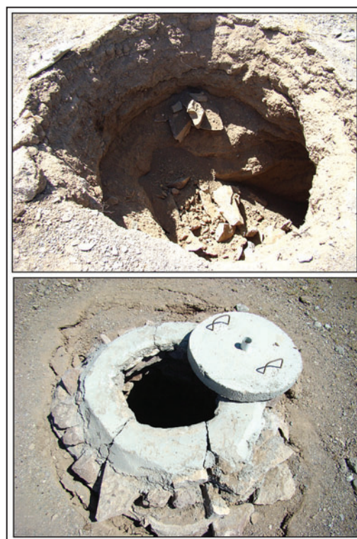
شکل ۱۴- ریزش دهانه چاه‌ها و قنات‌ها بر اثر لرزش‌های ناشی از زمین‌لرزه در آبادی دیان.
