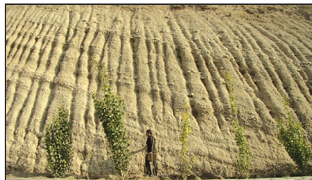
شکل ۲- برش کنار بزرگراه شیخ فضل الله تقاطع بزرگراه رسالت را نشان می‌دهد که لایه‌ها شیبی به سوی جنوب دارند (نگاه به سوی خاور).
