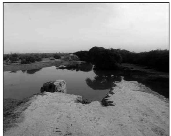
شکل ۱۸- تخریب بند خاکی پارک توسط سیلاب
