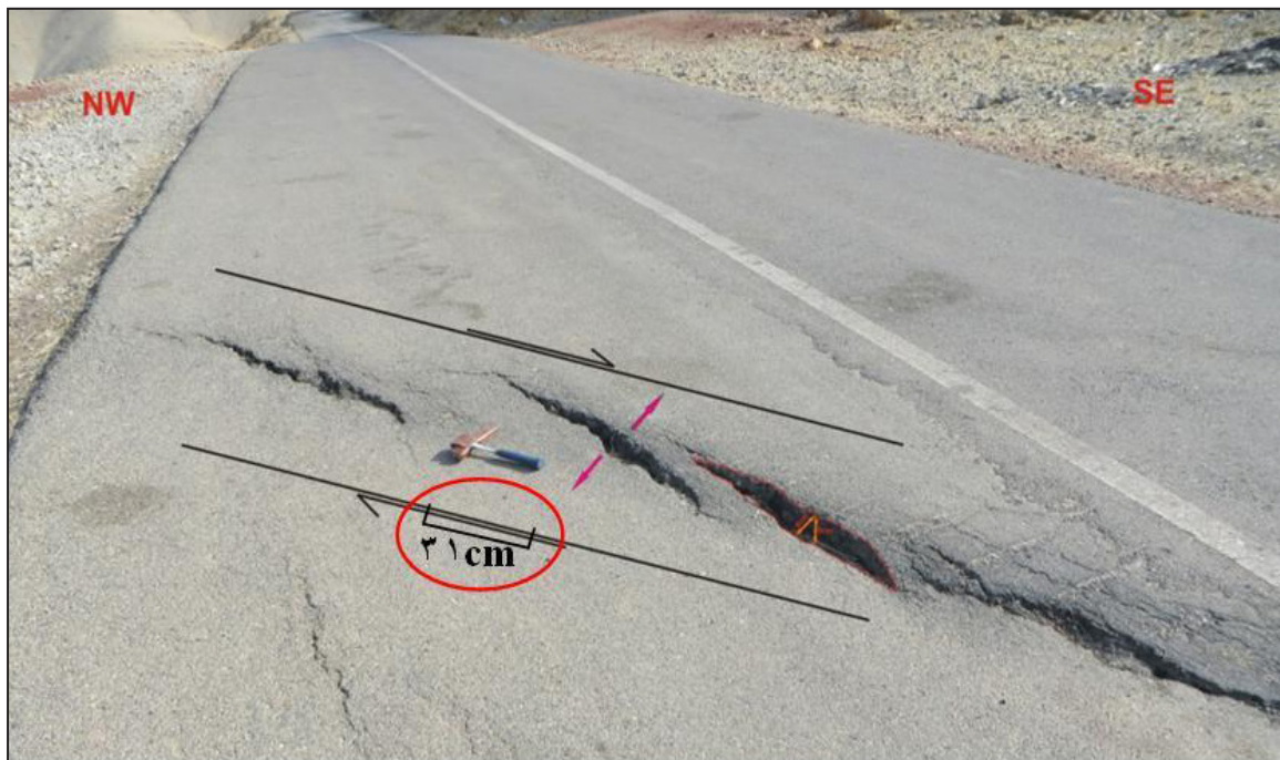
شکل ۳- شکستگی‌های تشکیل شده در اثر عملکرد گسل به طوری که به موازات امتداد اصلی گسل درود با روند شمال باختر- جنوب خاور و جابه‌جایی افقی و قائم اندازه‌گیری شده در برداشت صحرائی حدود ۸ سانتی‌متر بوده است.
