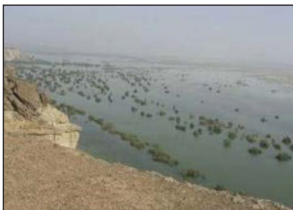
عکس ۴- نمایی از آب‌گرفتگی ناشی از سیلاب در واحد Q_m
